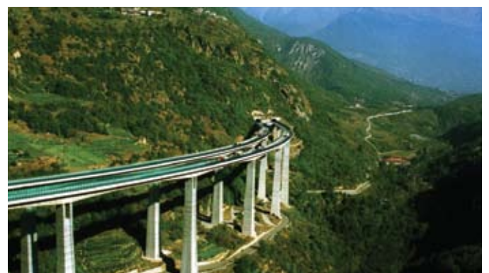
Autostrada A32 Torino-Bardonecchia - Viadotto Ramat A32 Highway Torino-Bardonecchia - Ramat viaduct
