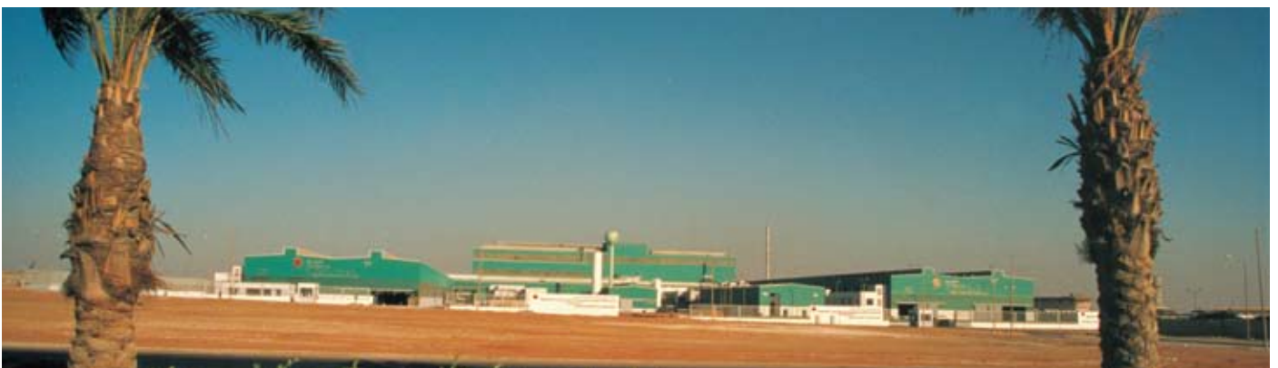
Acciaieria, Medio Oriente - Steel Plant, Middle East
